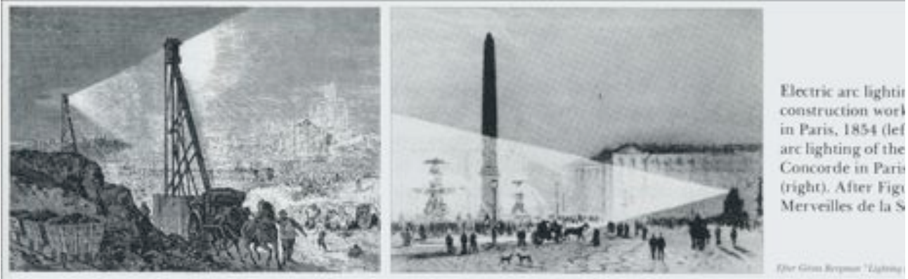
Elektrisk lys ved natarbejde i Paris 1854, og på Place de la Concorde 1844. Efter Figuier; Les Merveilles de la Science . Fra Gösta Bergman; Lighting in the Theatre , 1977
